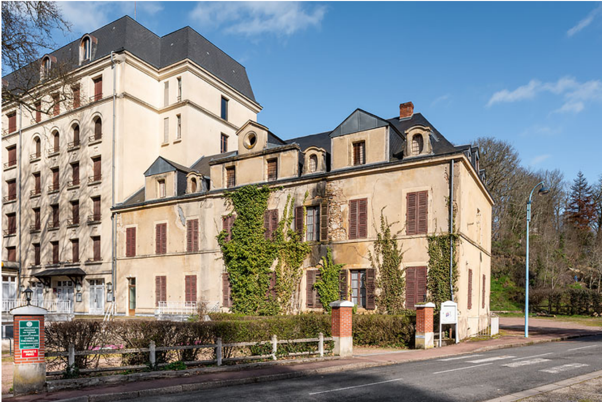
Façade principale, vue depuis le sud-ouest.
