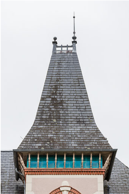
Tour demi-hors-œuvre, toiture et crête faîtière.
