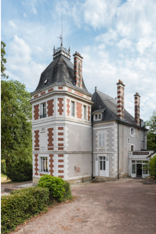
Pavillon nord, vue depuis le nord-est.
