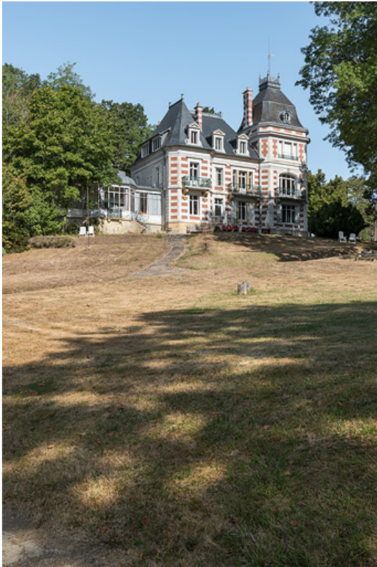
Façade, vue de trois-quarts depuis le sud.
