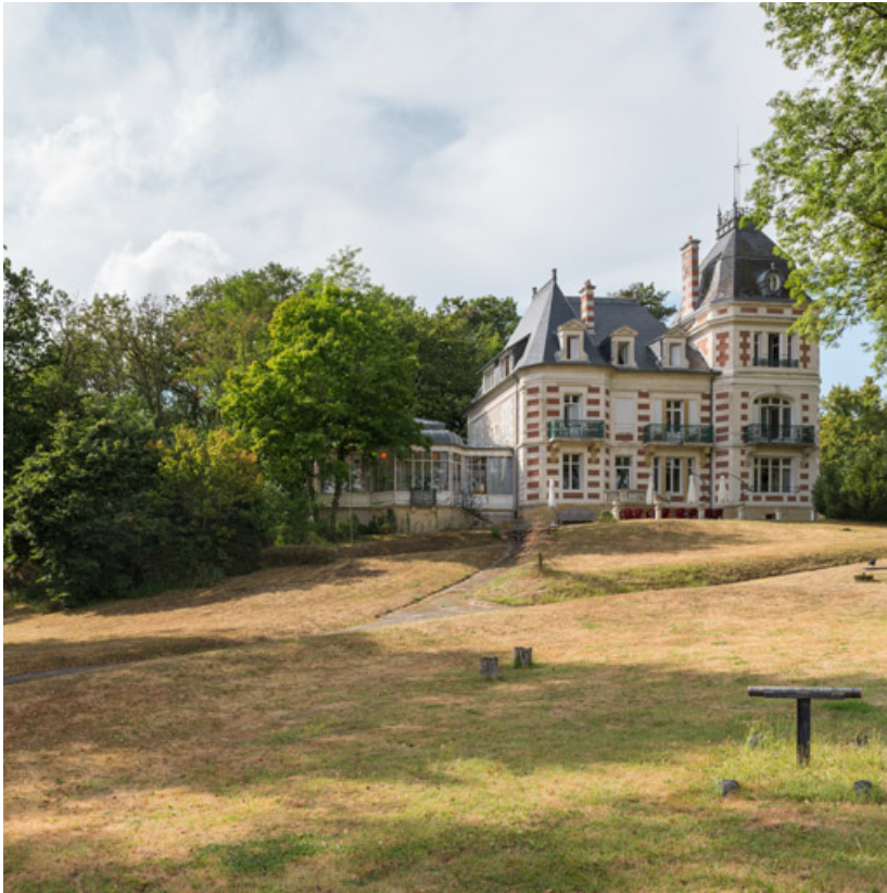
Façade, vue de trois-quarts depuis le sud.
