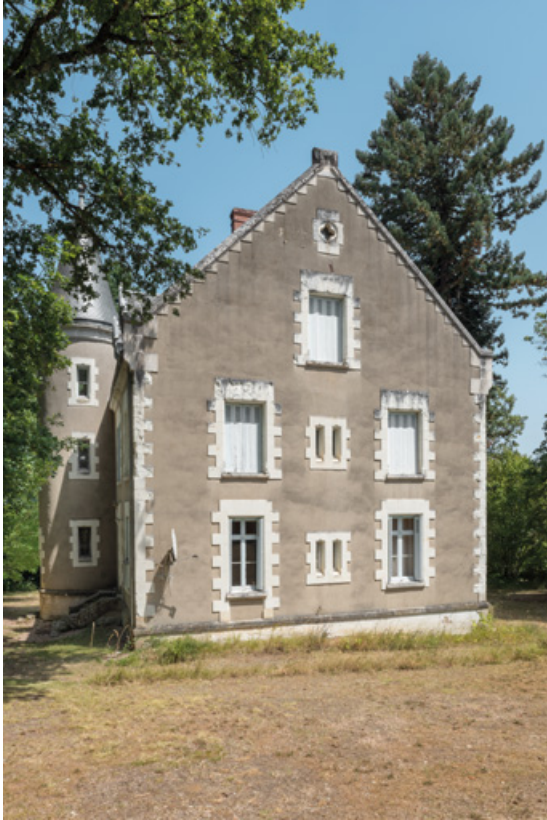
Mur pignon sud-ouest.
