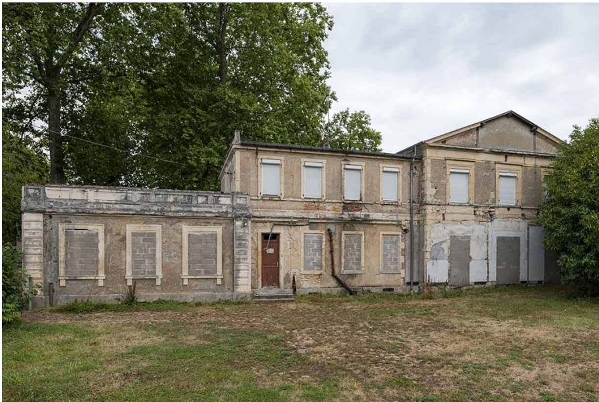
Façade postérieure, vue prise en 2020.
