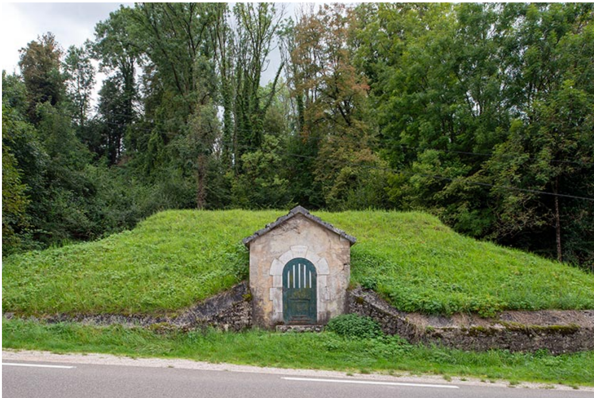
Réservoir de Veley (1910). Vue de face.
