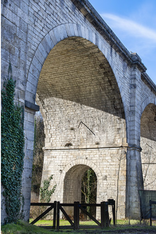
Vue rapprochée de l'arche est.
