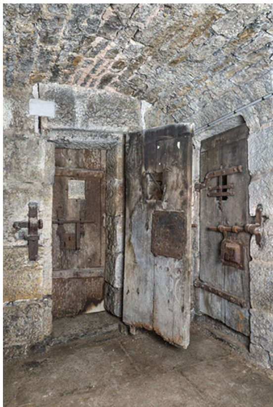
Cellules de l'angle sud-est.
