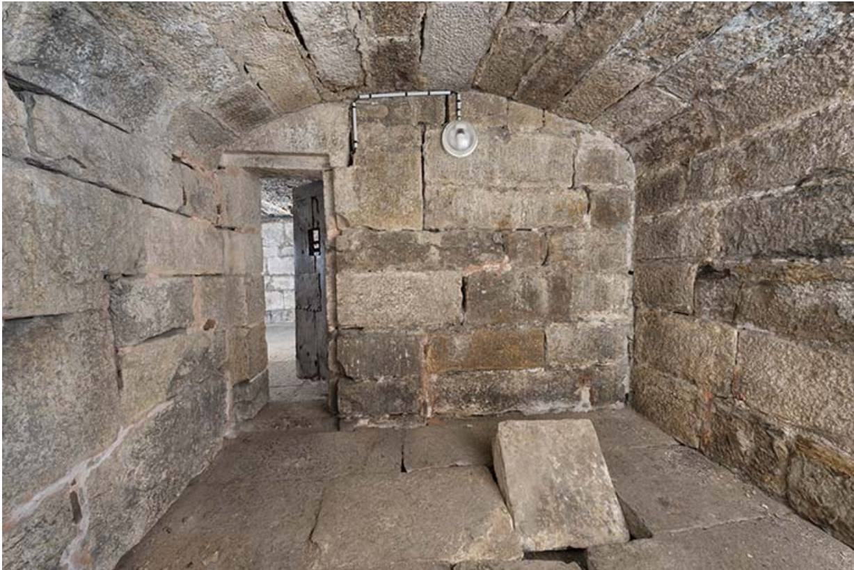
Intérieur d'une cellule.
