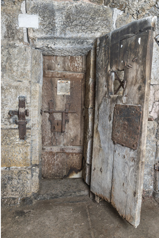
Portes doubles d'une cellule.
