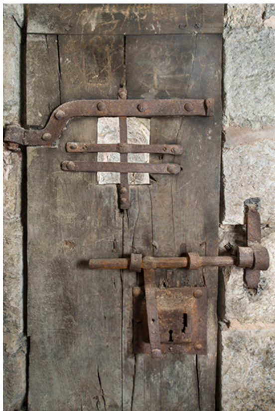
Vue rapprochée d'une porte.
