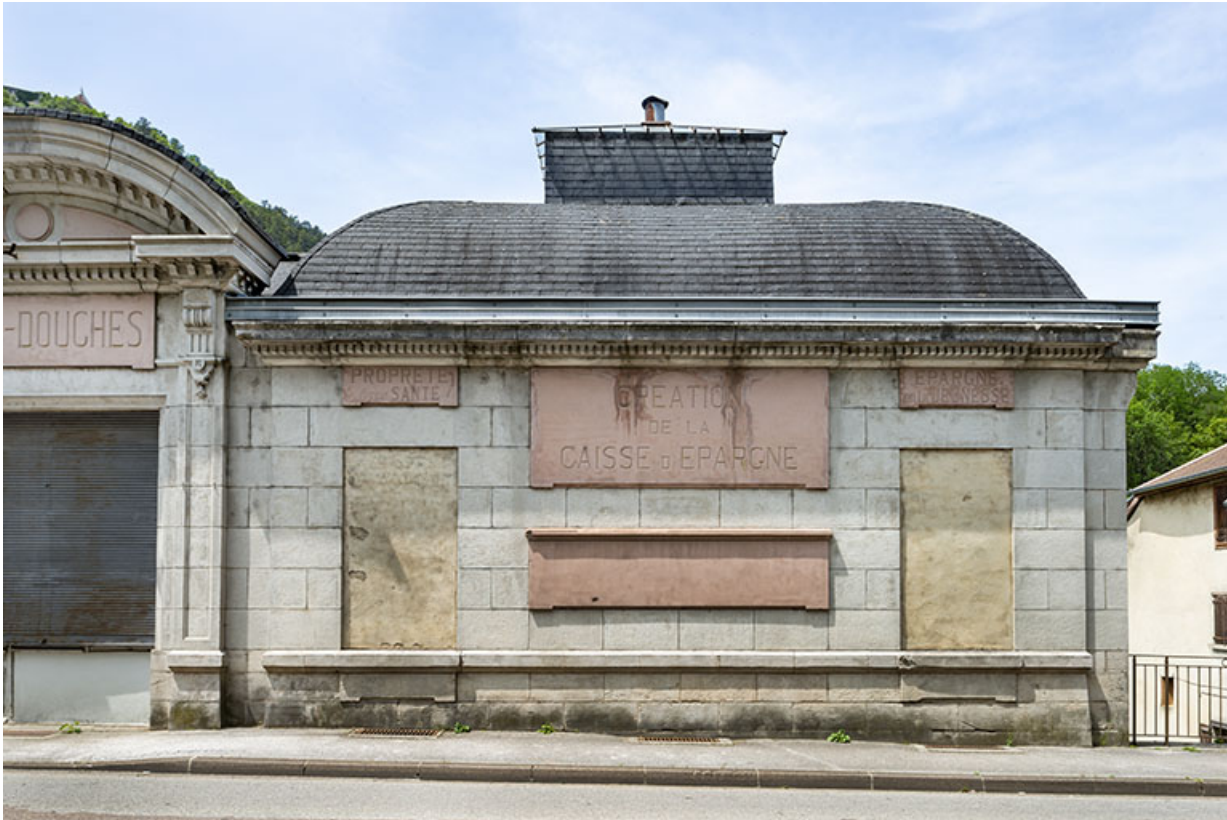
Elévation sur rue du pavillon nord.
