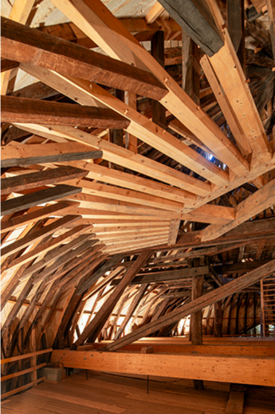
Coté nord, vu depuis l'ouest.
