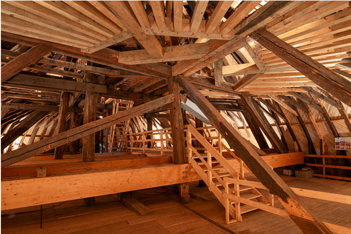
Vue d'ensemble depuis le nord-ouest. Vue rapprochée.
