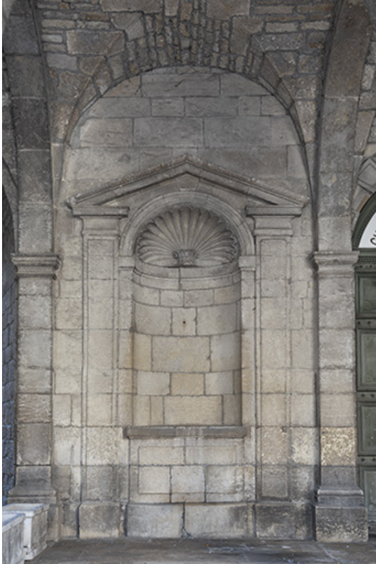
Façade antérieure du parvis. Niche sud.
