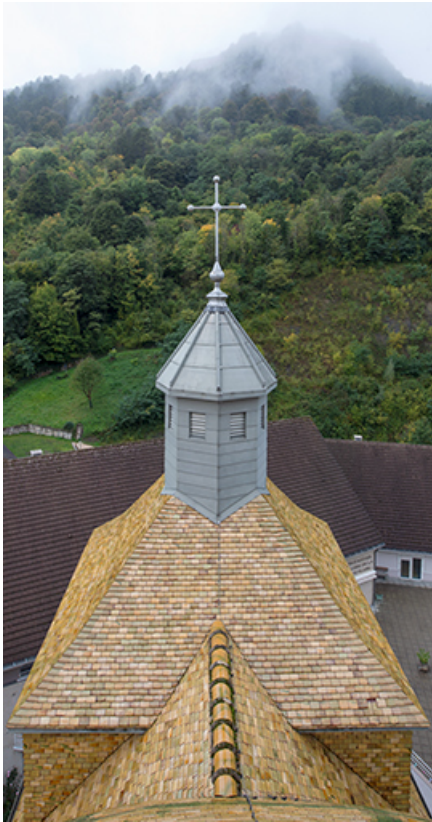
Toiture de la sacristie, depuis le lanterneau.
