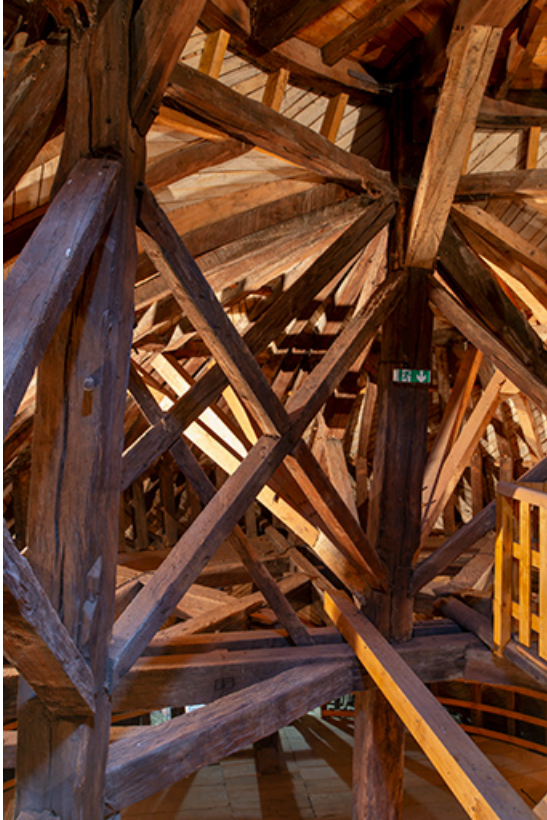
Entretoise du niveau intermédiaire, côté nord.
