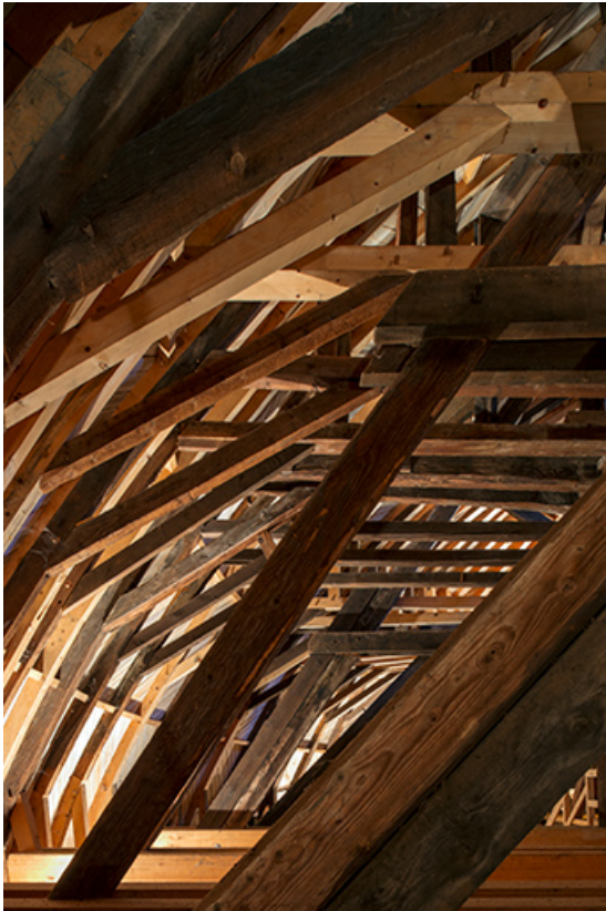
Côté sud de la charpente du dôme.
