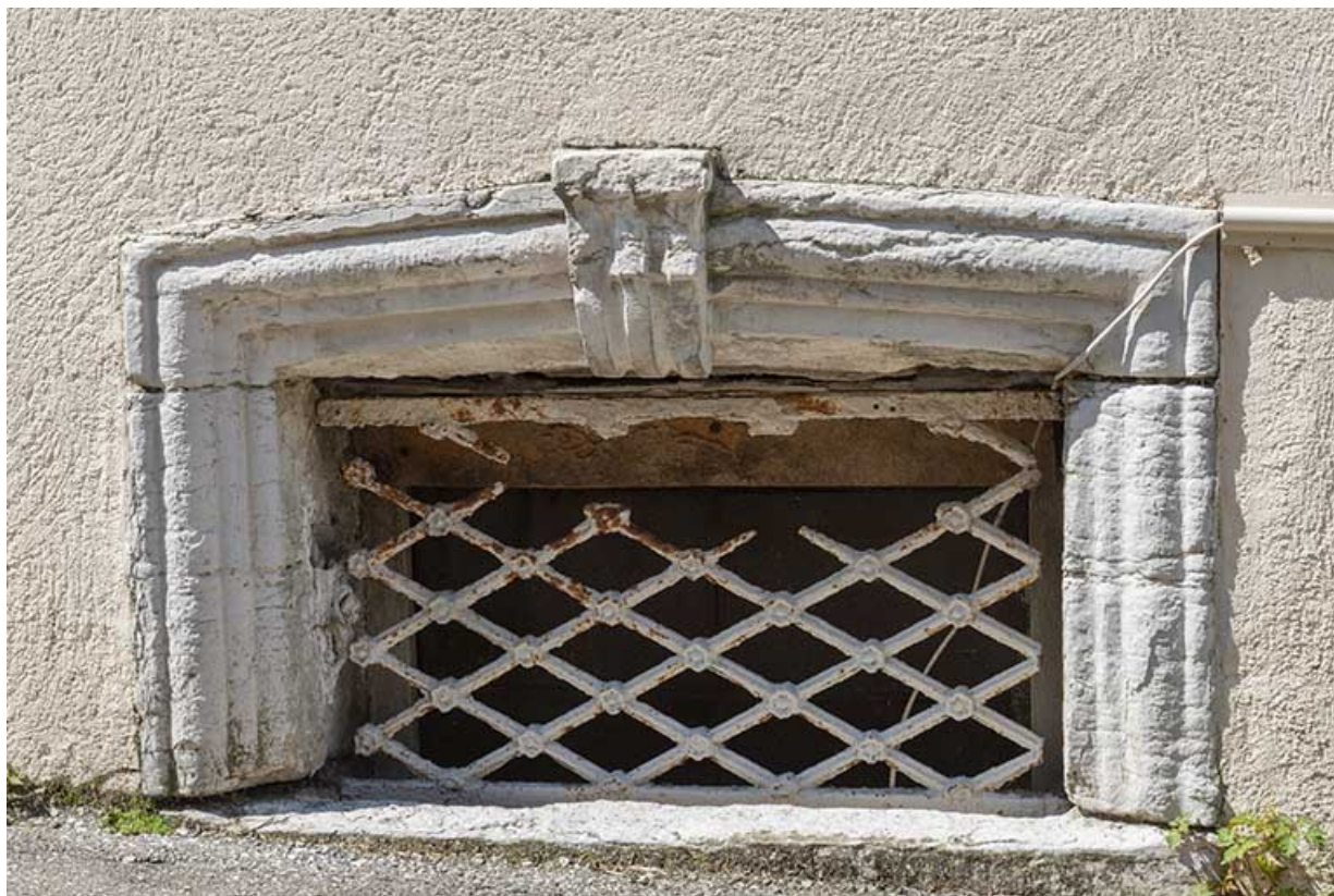
Façade antérieure. Soupirail.
