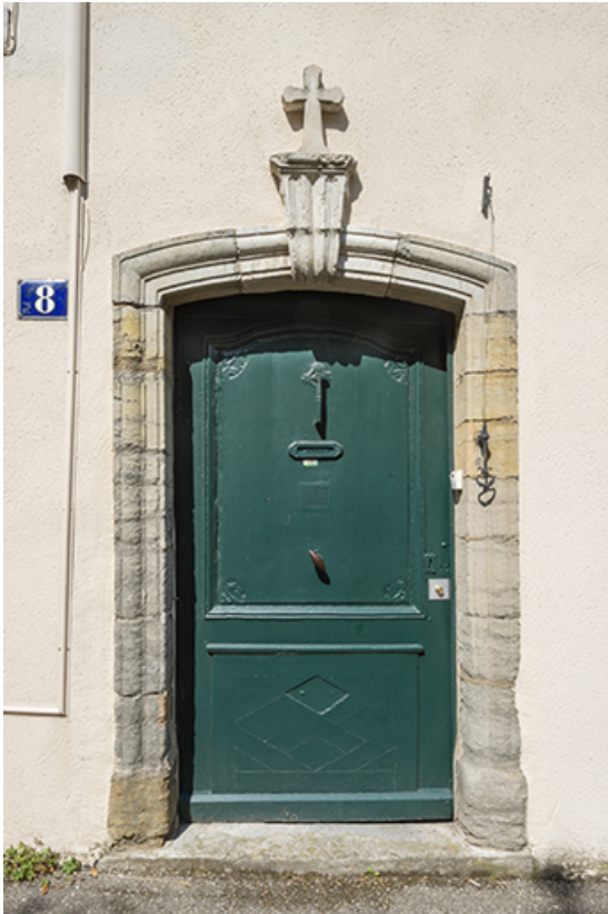
Façade antérieure. Détail de la porte.
