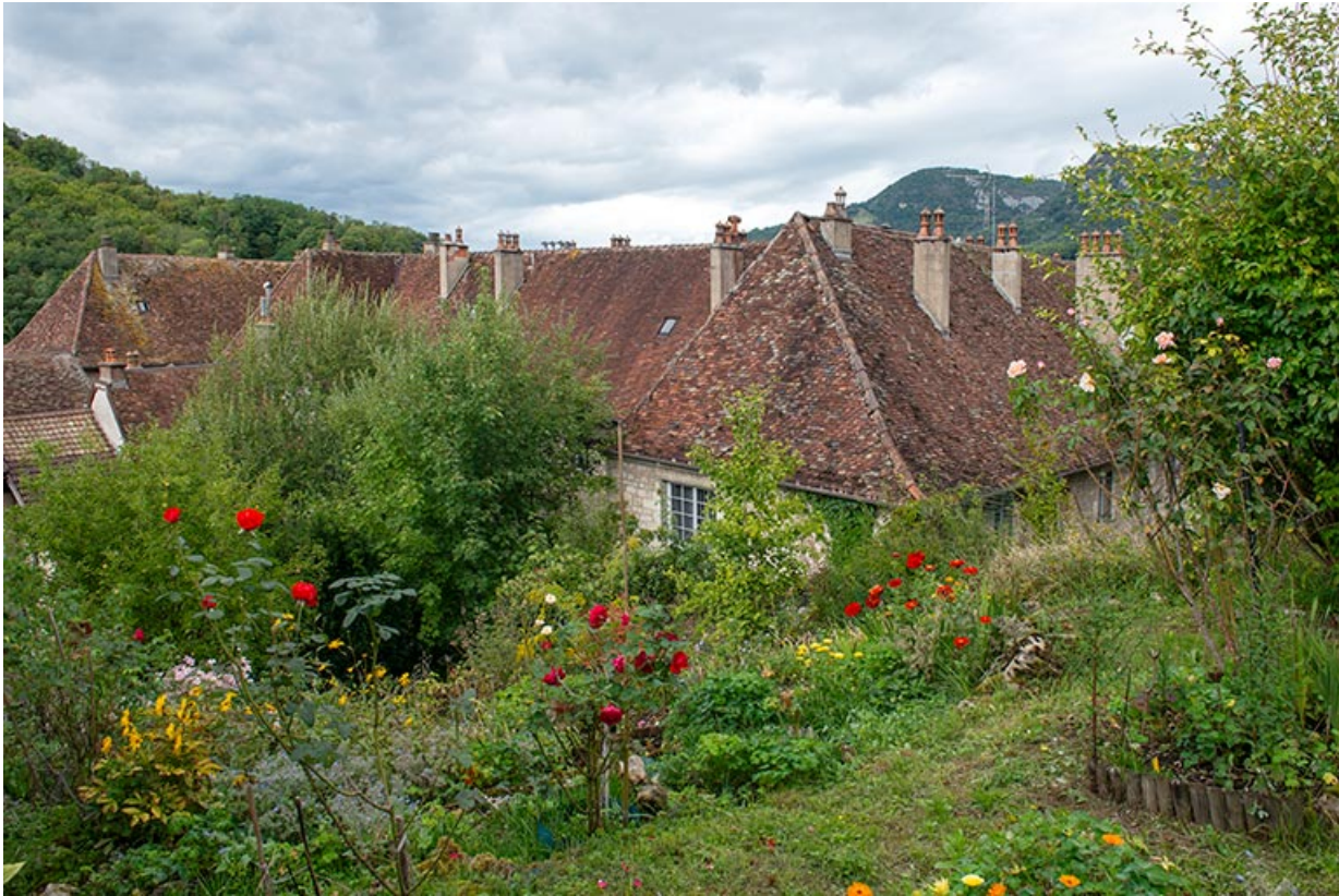
Toitures du couvent, depuis le sud-est.
