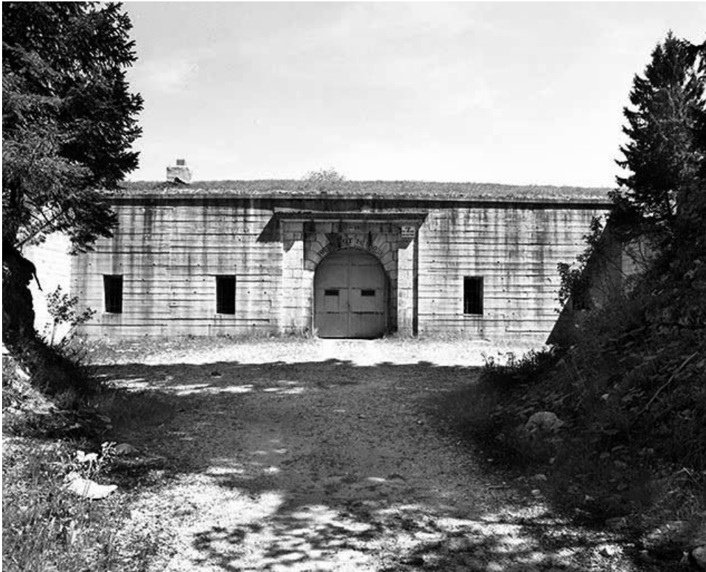
Façade antérieure, vue éloignée.
