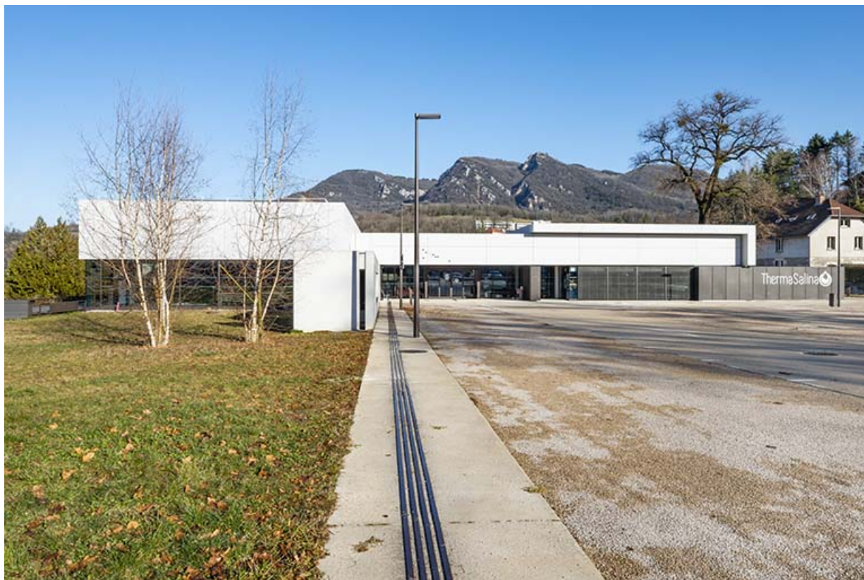
Vue depuis le sud.
