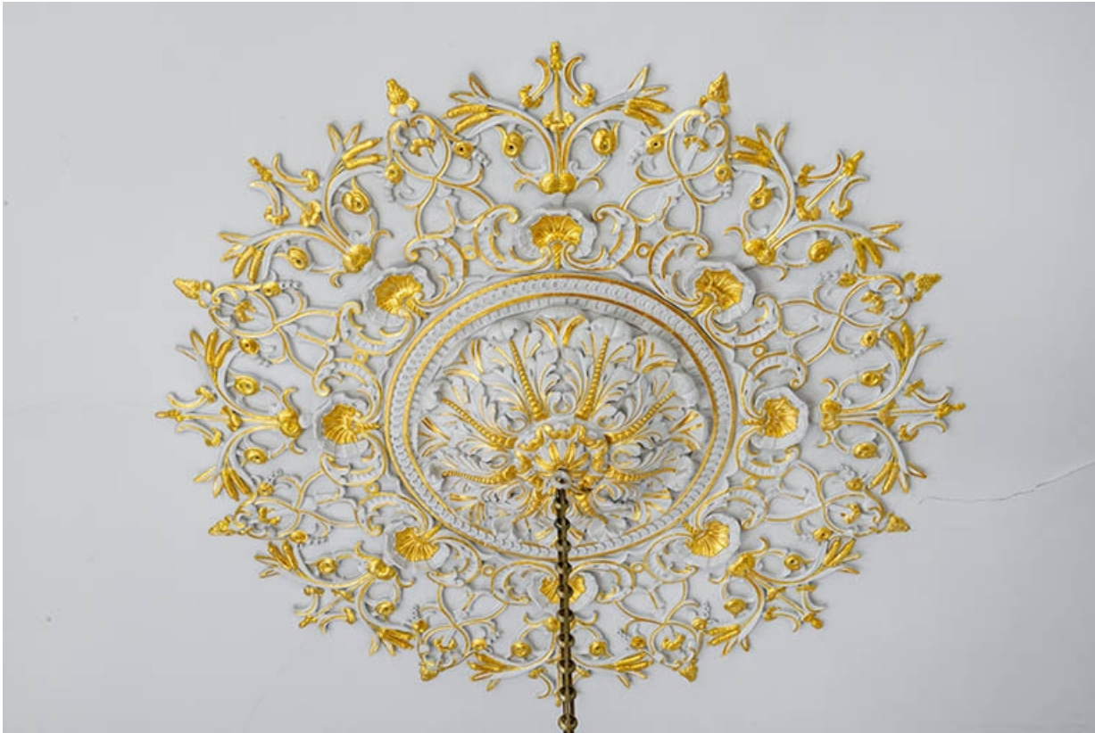
Salle de restaurant, plafond, détail.
