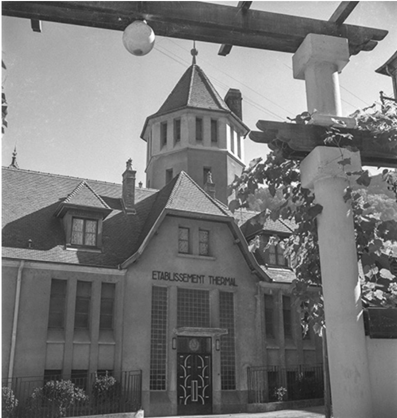
Entrée de l'établissement, s.d. [vers 1960].
