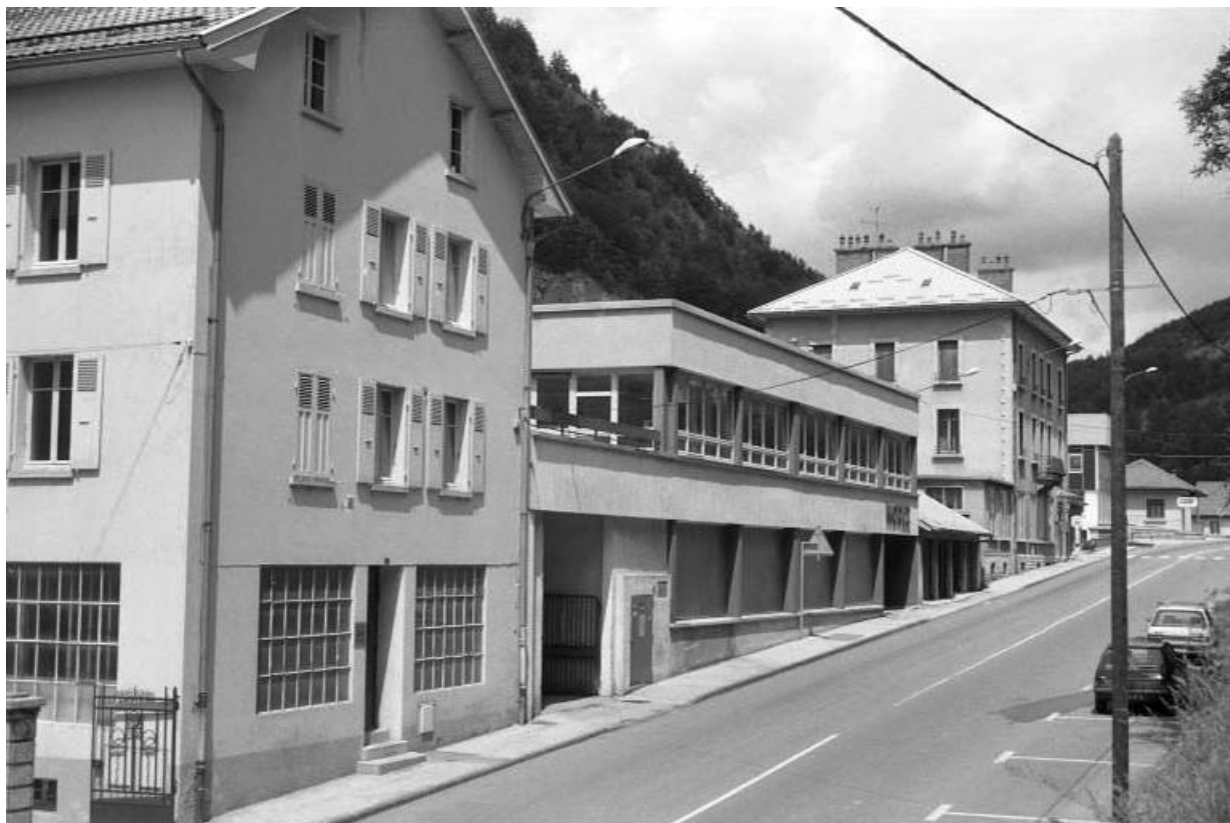
Avenue Charles de Gaulle : vue d'ensemble.
