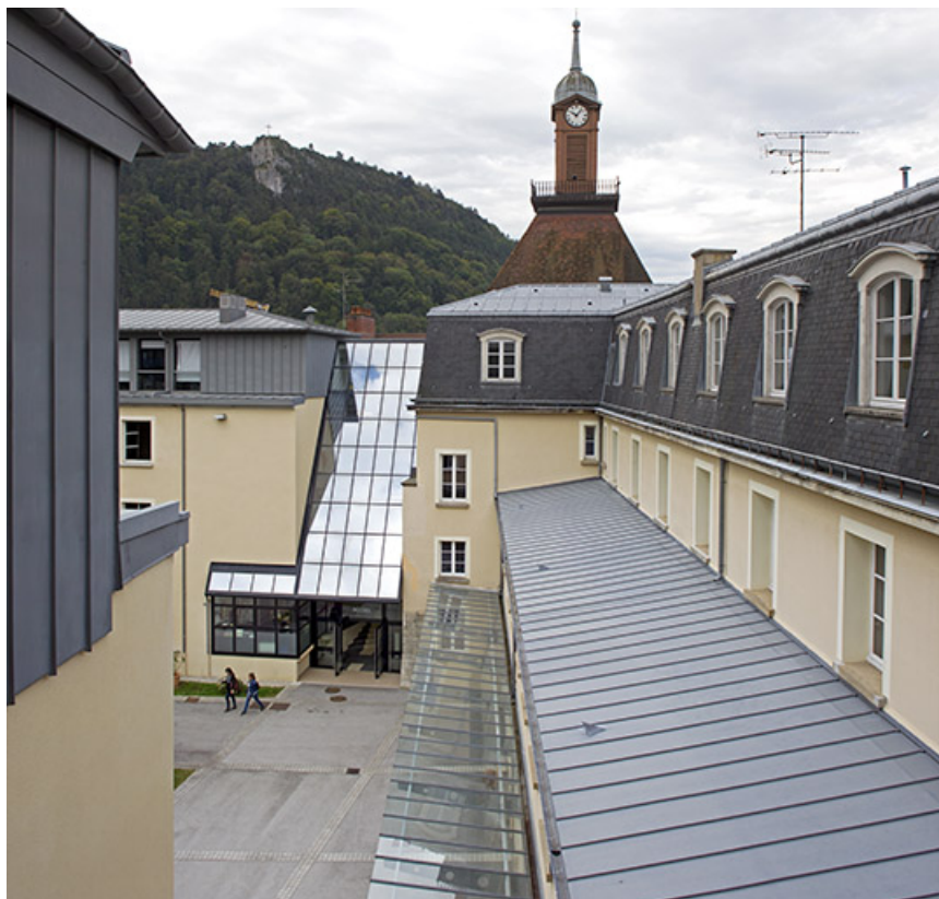
Aile Ouest : toitures at auvents.
