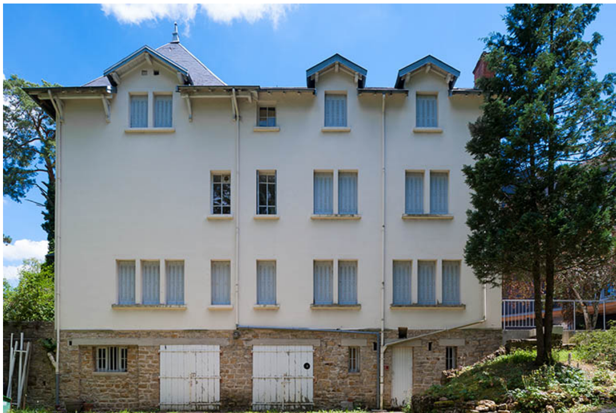
Chalet Colette : façade postérieure de l'aile ouest.
