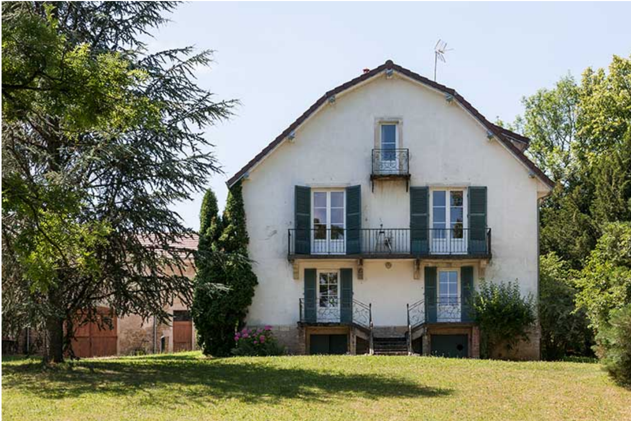
Pavillon du proviseur : façade antérieure.
