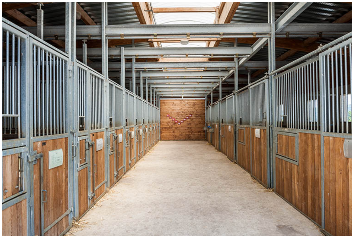
Centre équestre : boxes d'enseignement, allée centrale.
