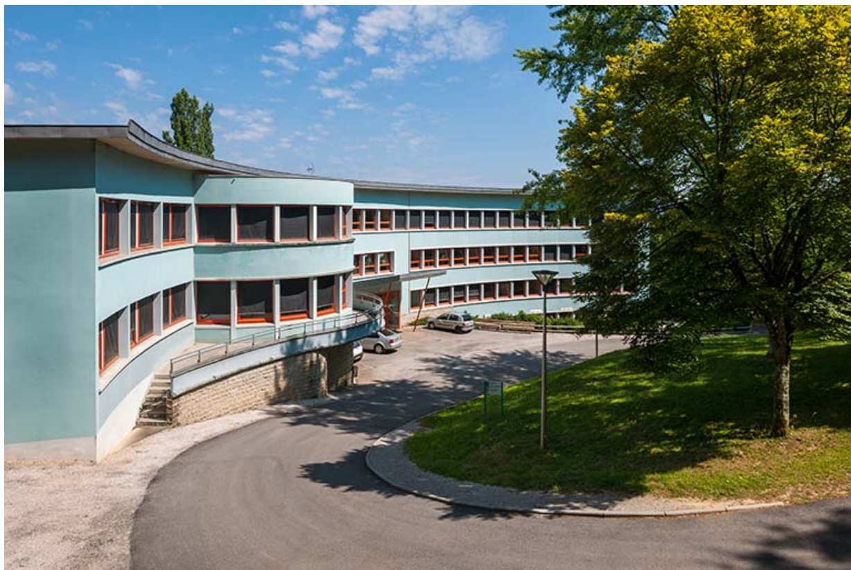
Internat : vue sud.
