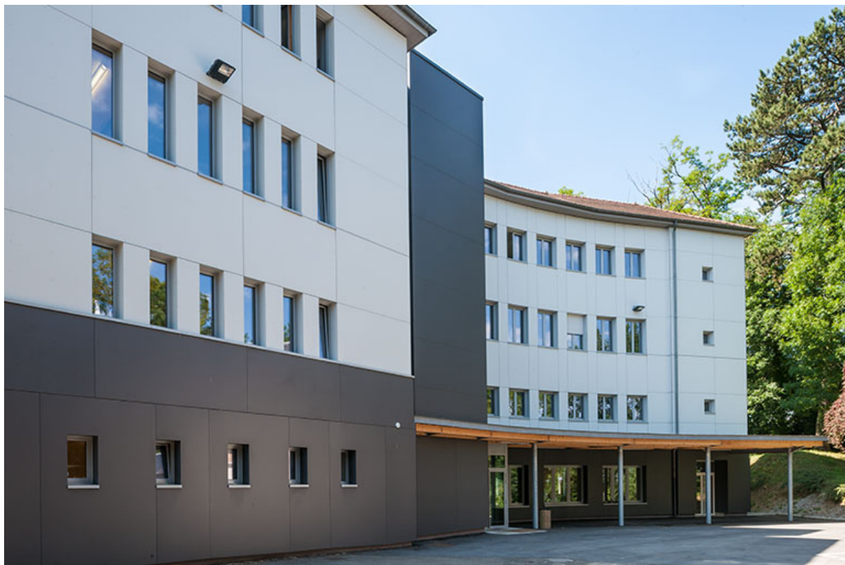
Externat : aile ouest , façade antérieure.
