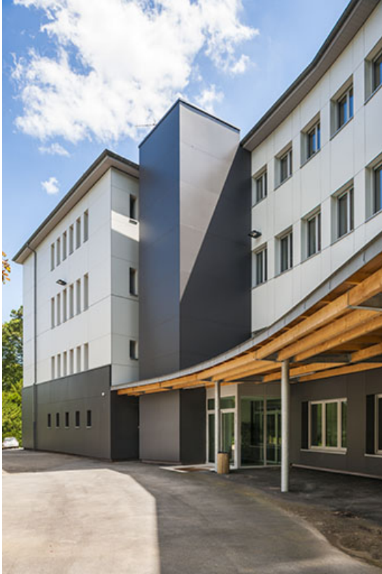
Externat, façade postérieure : détail.
