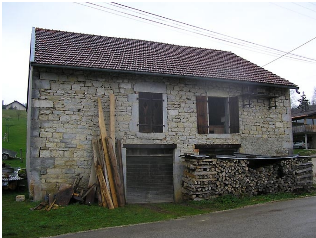
Vue générale sur façade antérieure.
