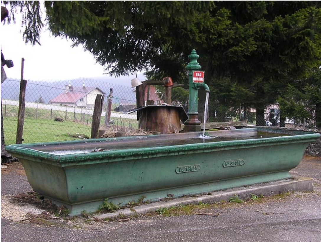
Vue de trois quarts sur ensemble hydraulique.
