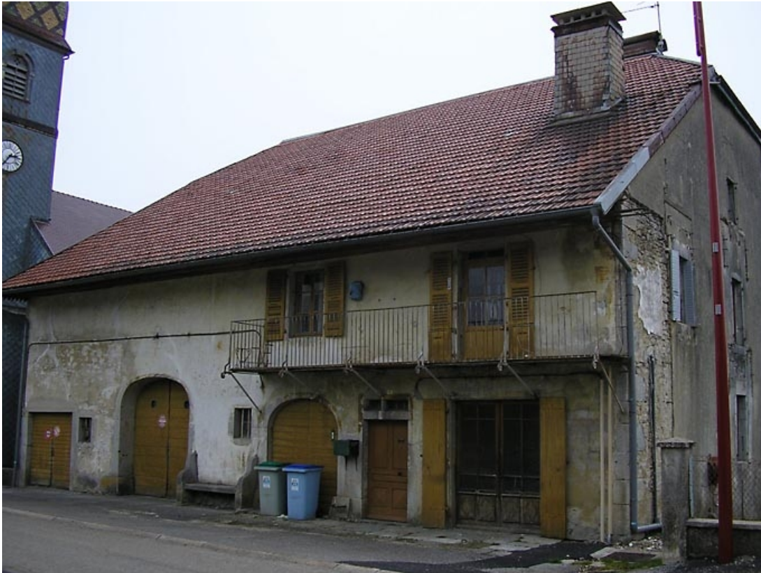
Vue de trois quarts sur façade antérieure.
