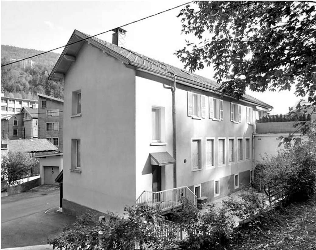
Elévation postérieure, de trois quarts gauche.
