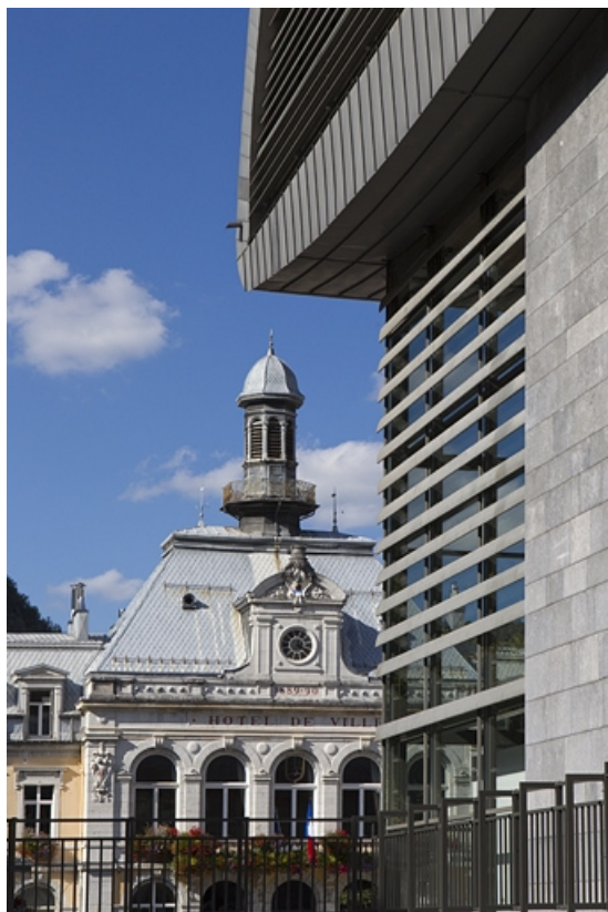
Façade latérale droite : détail.
