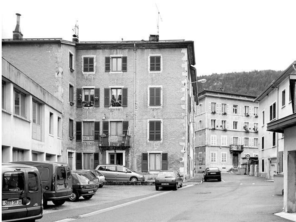
Bâtiment au n° 21, vu du nord.
