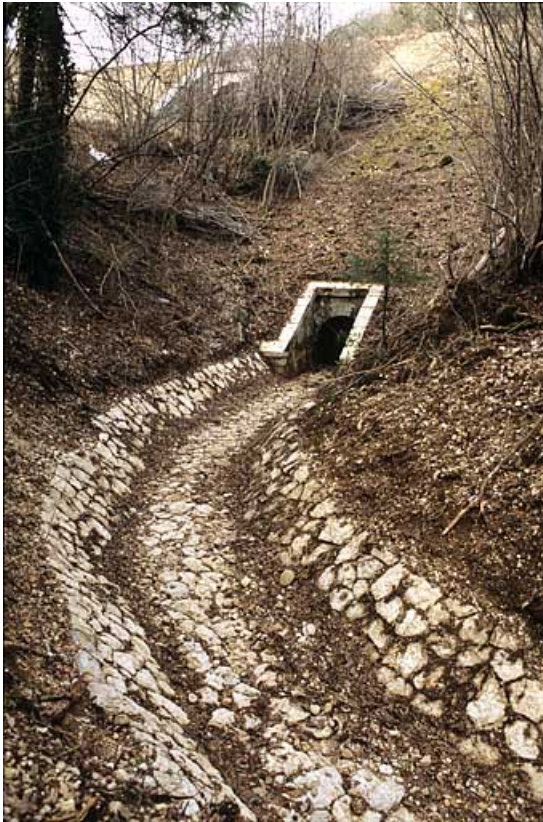
Aqueduc : tête aval (ouest) et rigole.
