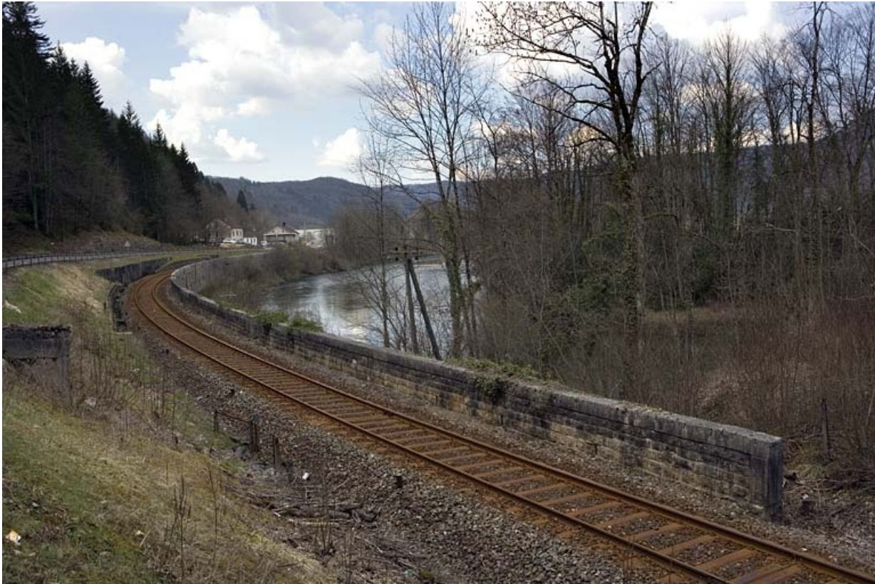
Vue d'ensemble, depuis le côté Andelot-en-Montagne.
