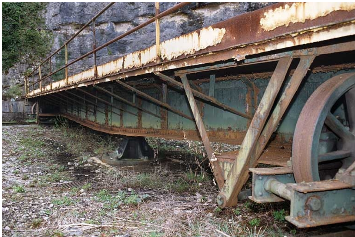
Tablier vu en enfilade.
