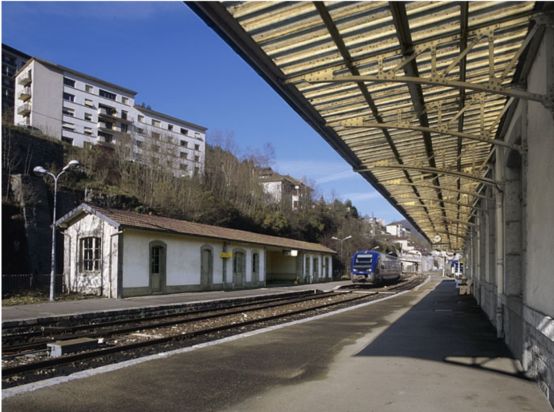
Abri-lampisterie : façade antérieure, de trois quarts gauche.
