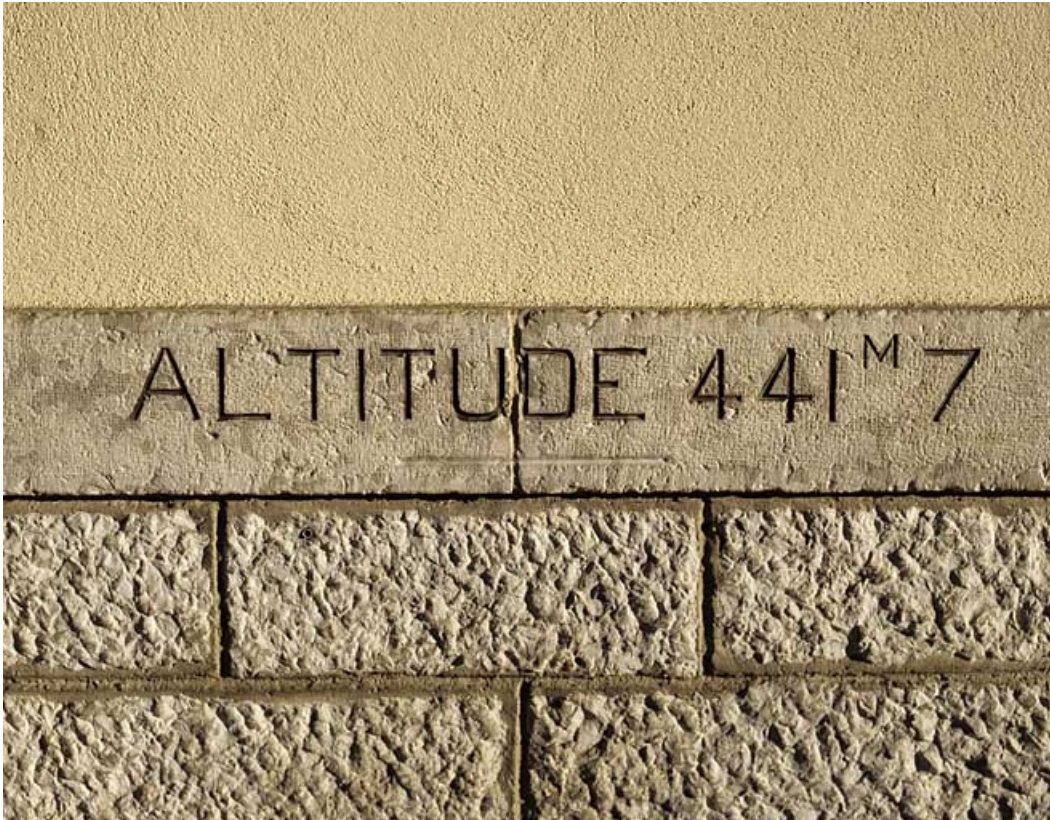
Bâtiment des voyageurs : inscription altimétrique.
