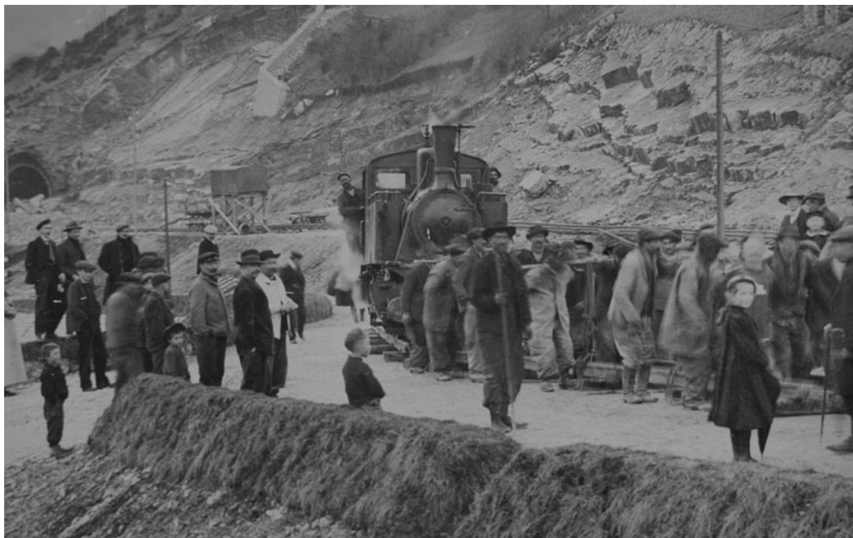
[Pose d'une voie provisoire côté Andelot-en-Montagne], 1912.
