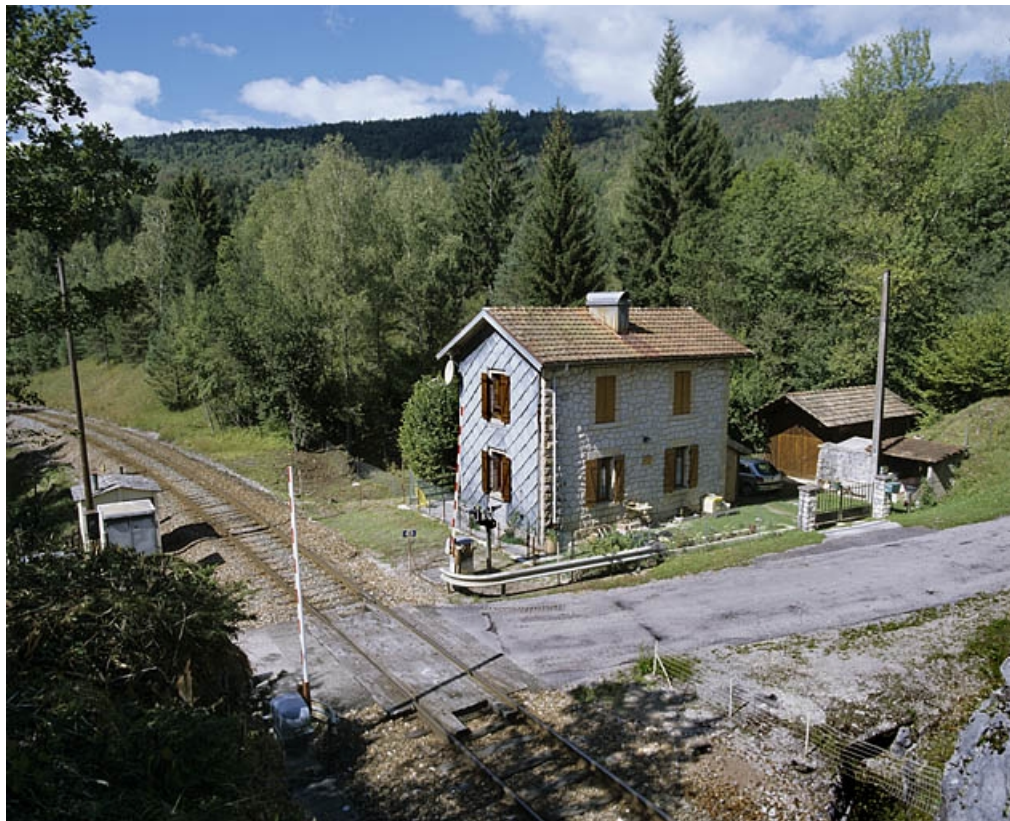
Vue d'ensemble plongeante, depuis le sud-est.
