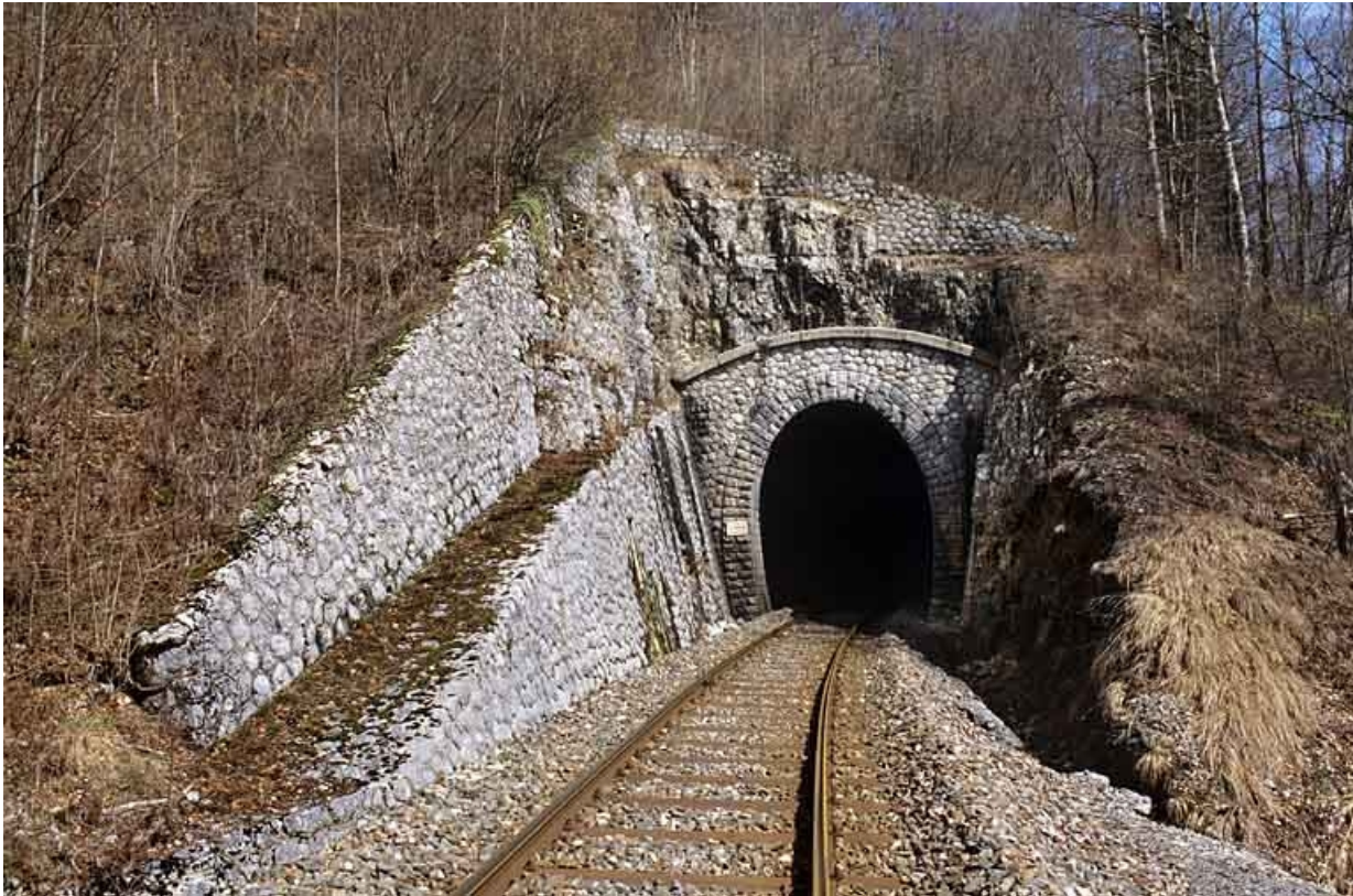
Tunnel du Chalet : vue d'ensemble, côté La Cluse (sud). À gauche, mur en aile sur deux niveaux.
