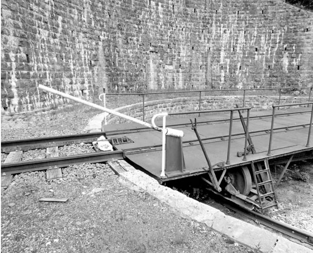
Barre permettant de faire pivoter le pont. 39, Morez, 15, 17 avenue Charles de Gaulle
