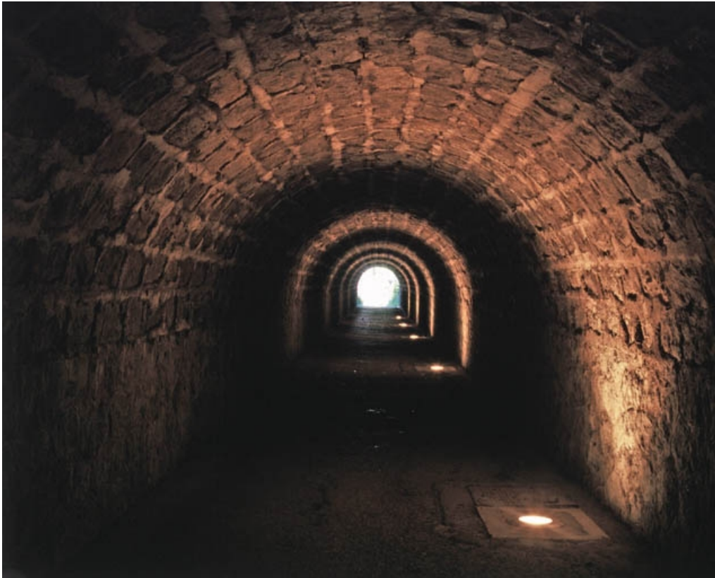
Passage souterrain (sous les voies) : intérieur.
