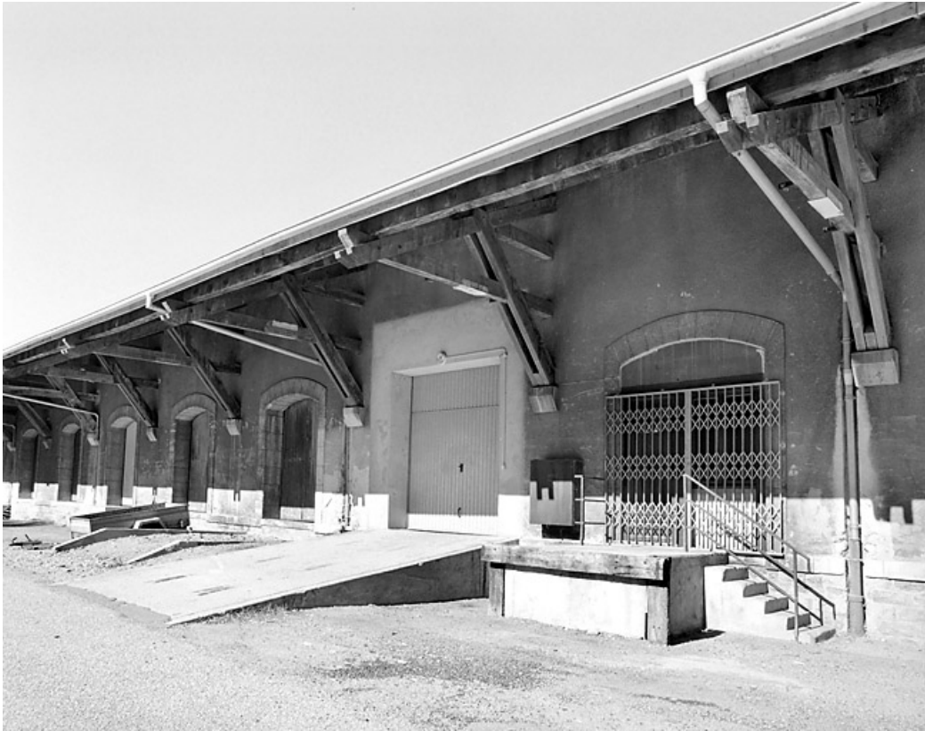
Entrepôt : façade antérieure.
