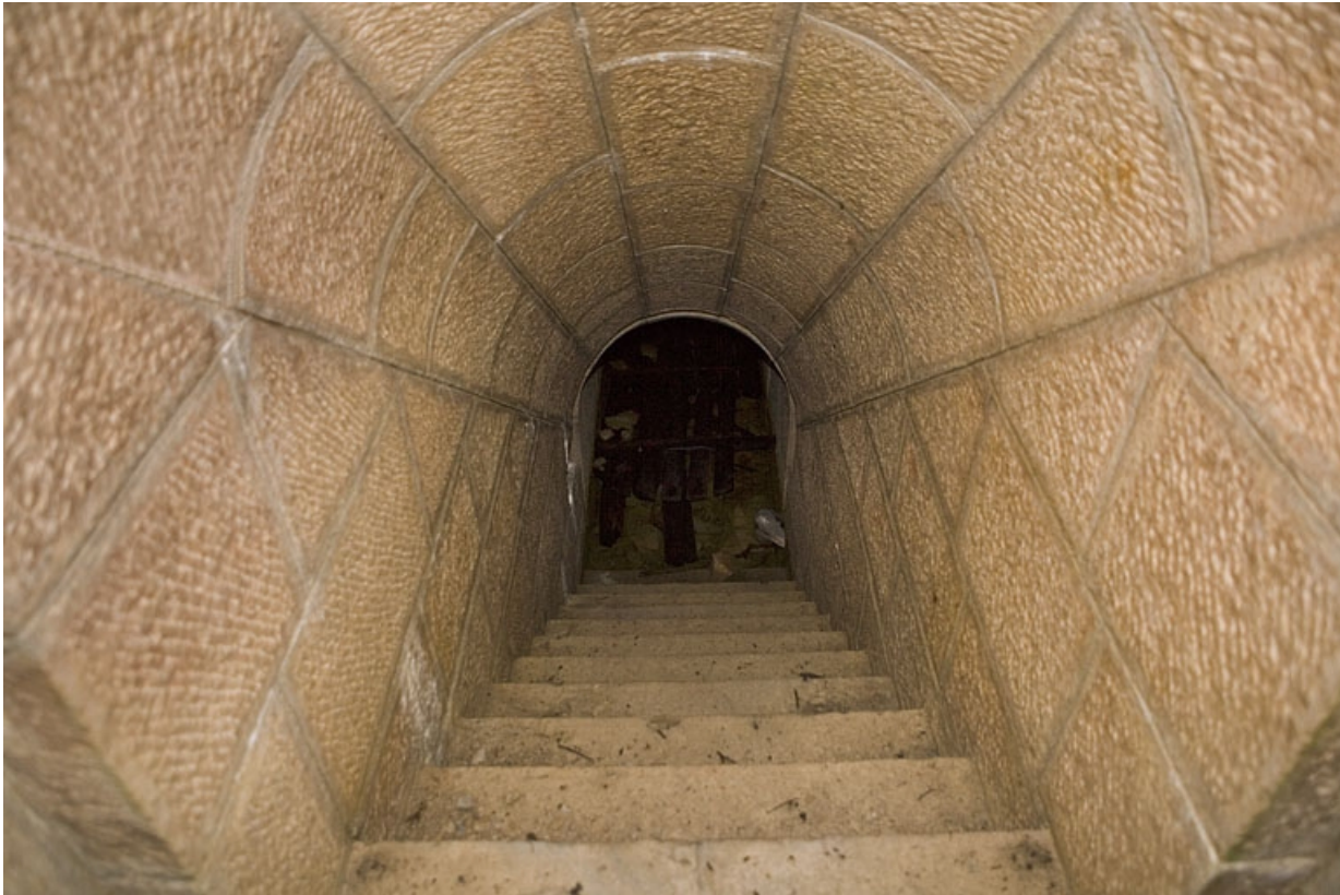
Chambres de mine centrale : escalier.
