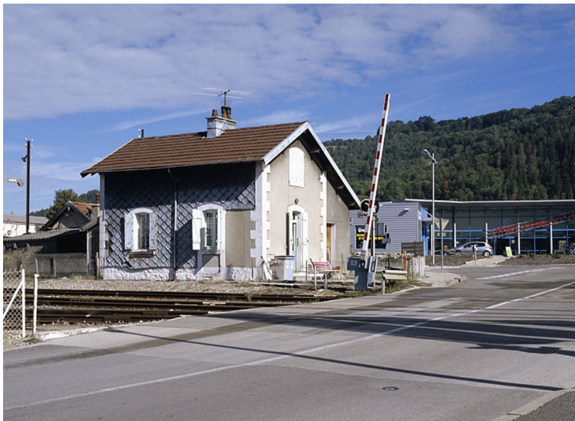
Façades antérieure et latérale gauche.
