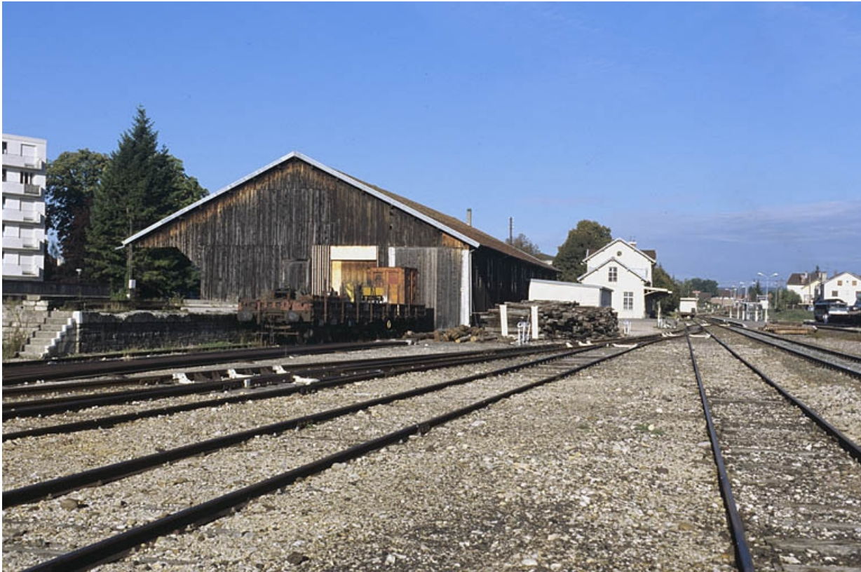
Entrepôt : vue d'ensemble, depuis le sud-est.
