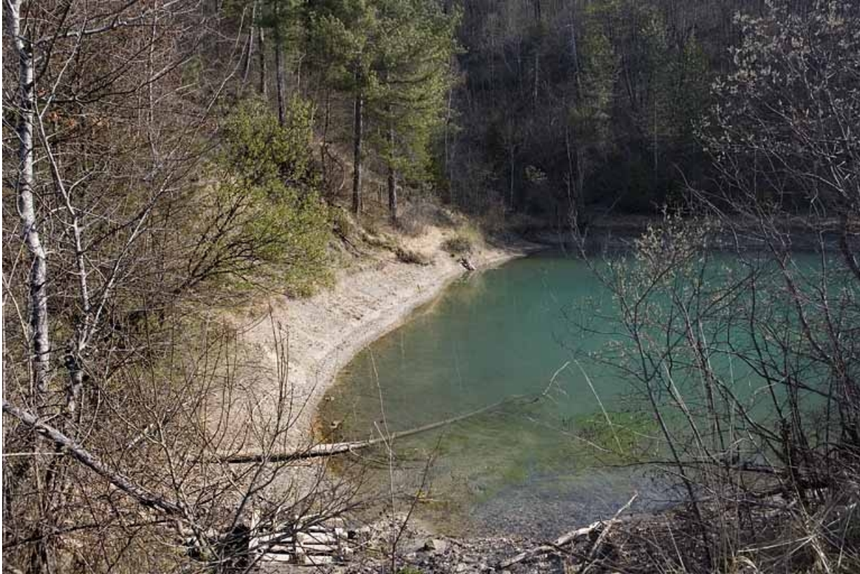
Réservoir, depuis l'ouest.
