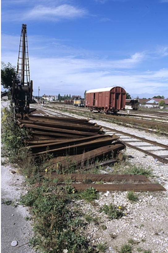
Grue, voies, wagon et traverses métalliques.
