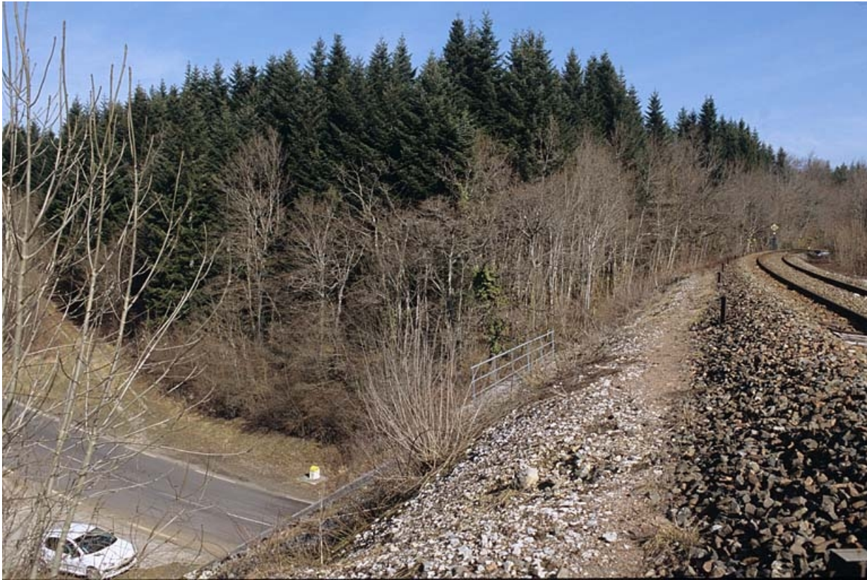
Plate-forme, depuis la voie côté La Cluse.
