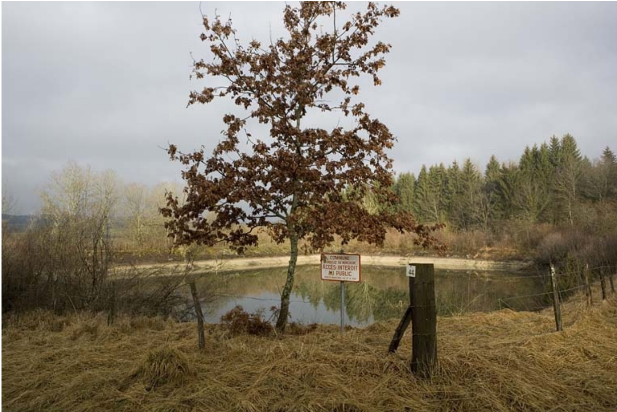
Réservoir, Pâturage de Montsevely : vue d'ensemble.
