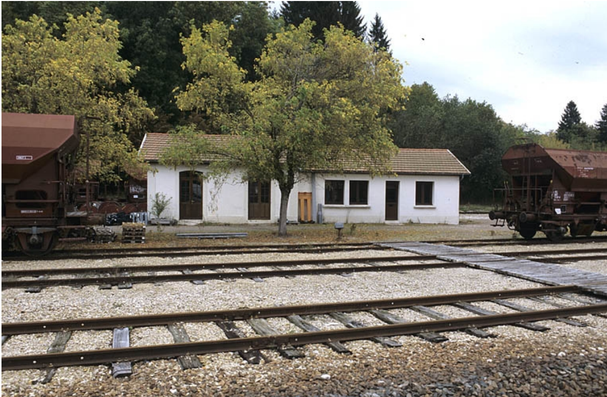
Ancienne lampisterie (bureau des électriciens), de face.
