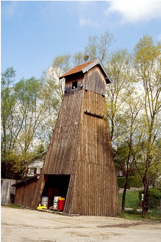
Chevalement du puits n° 7.
