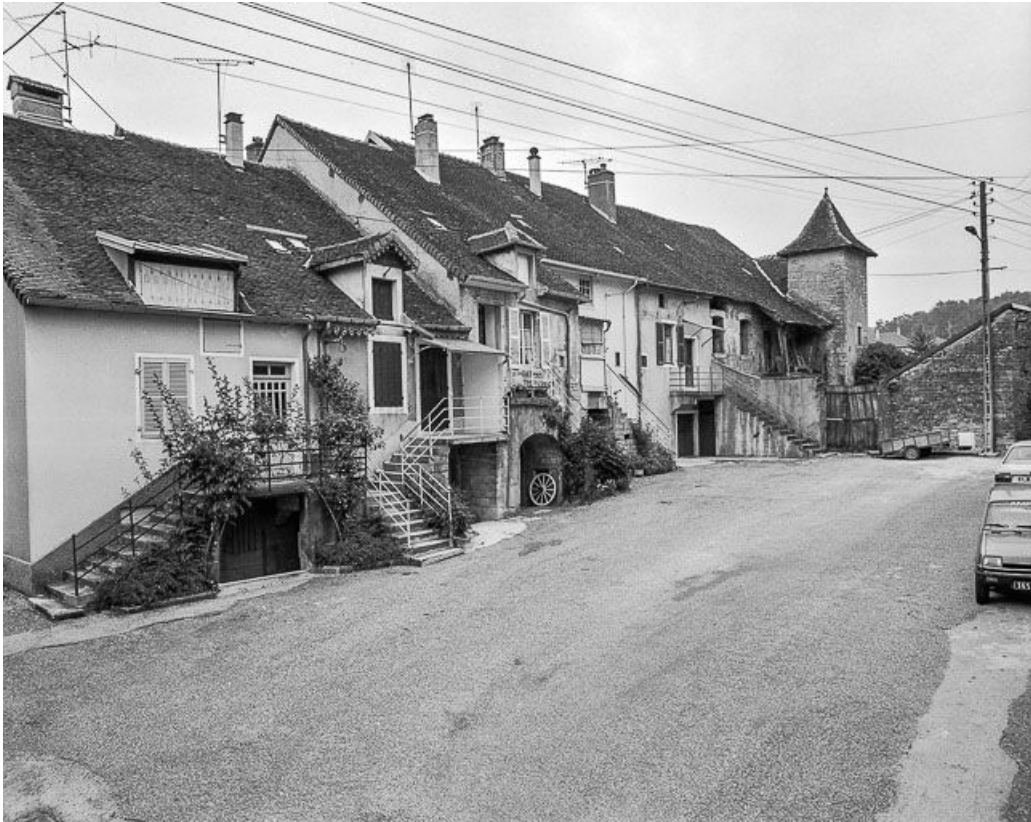
Maisons situées rue des Micholettes : façades antérieures.
