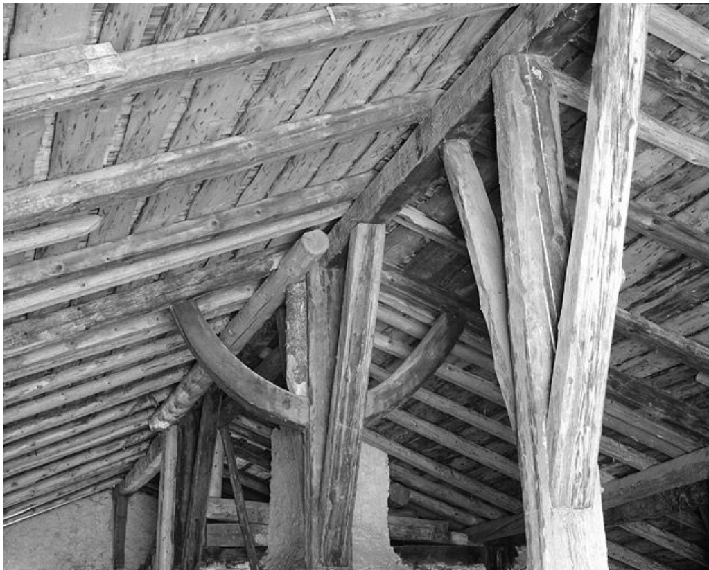
Charpente, colonne sous faitage et contrefiche.
