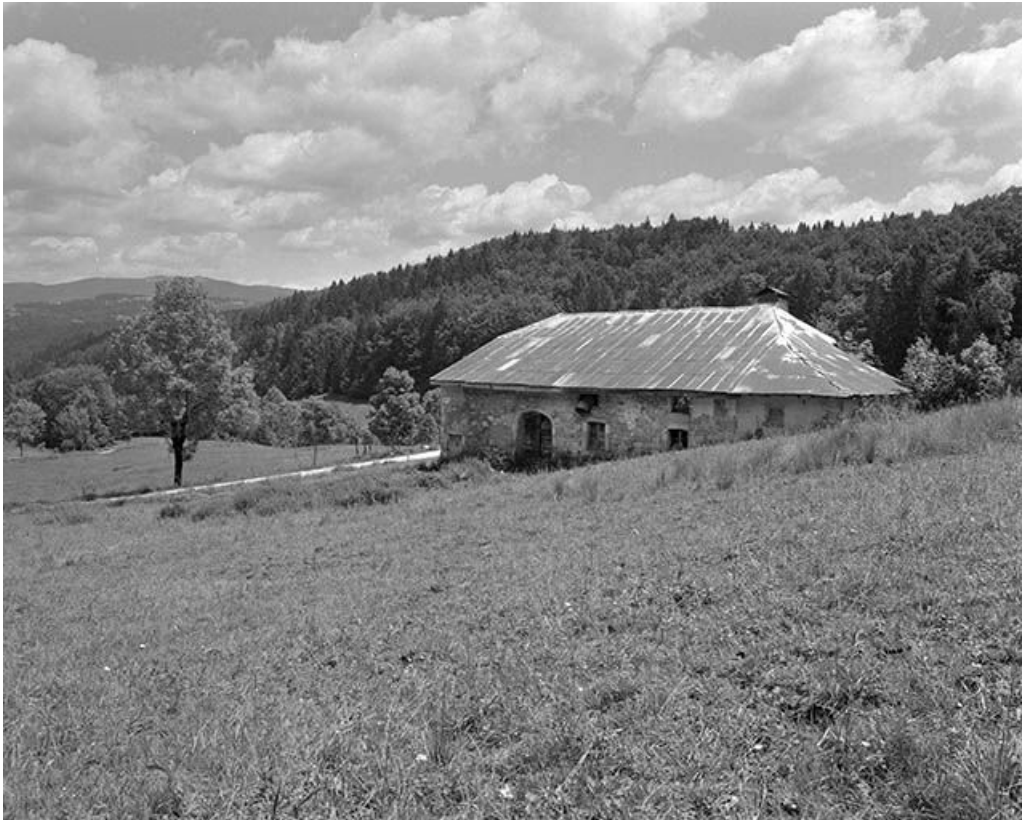
Vue éloignée de la façade postérieure.
