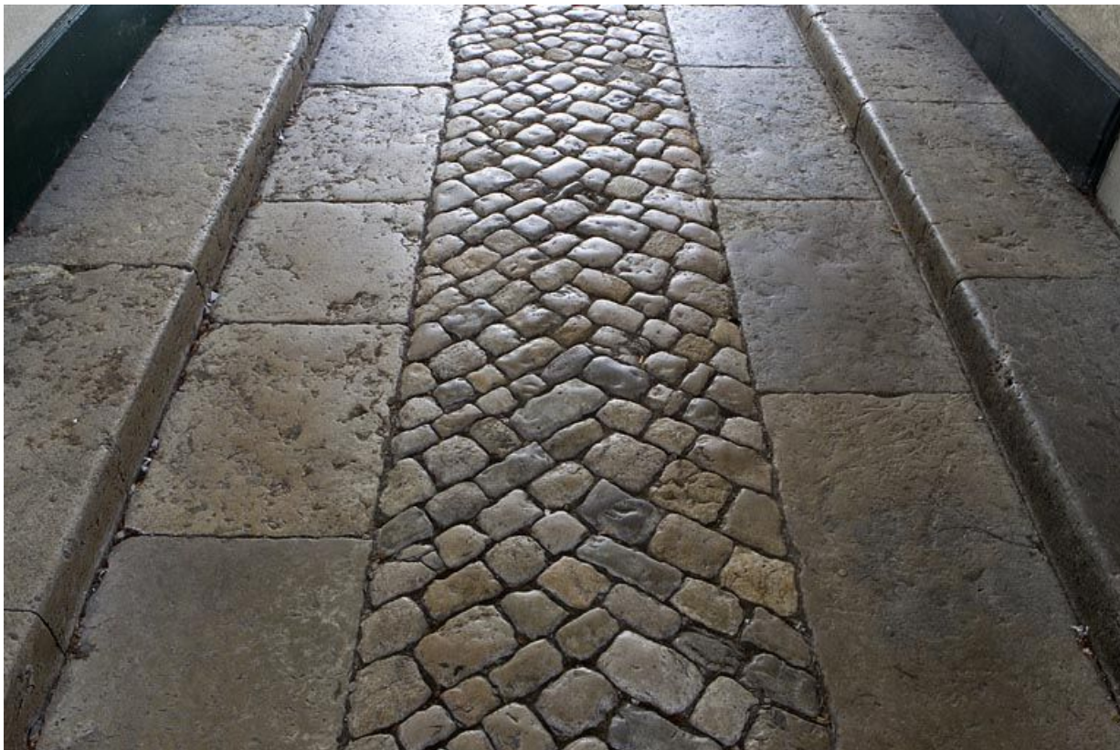
Passage couvert : sol de galets.
