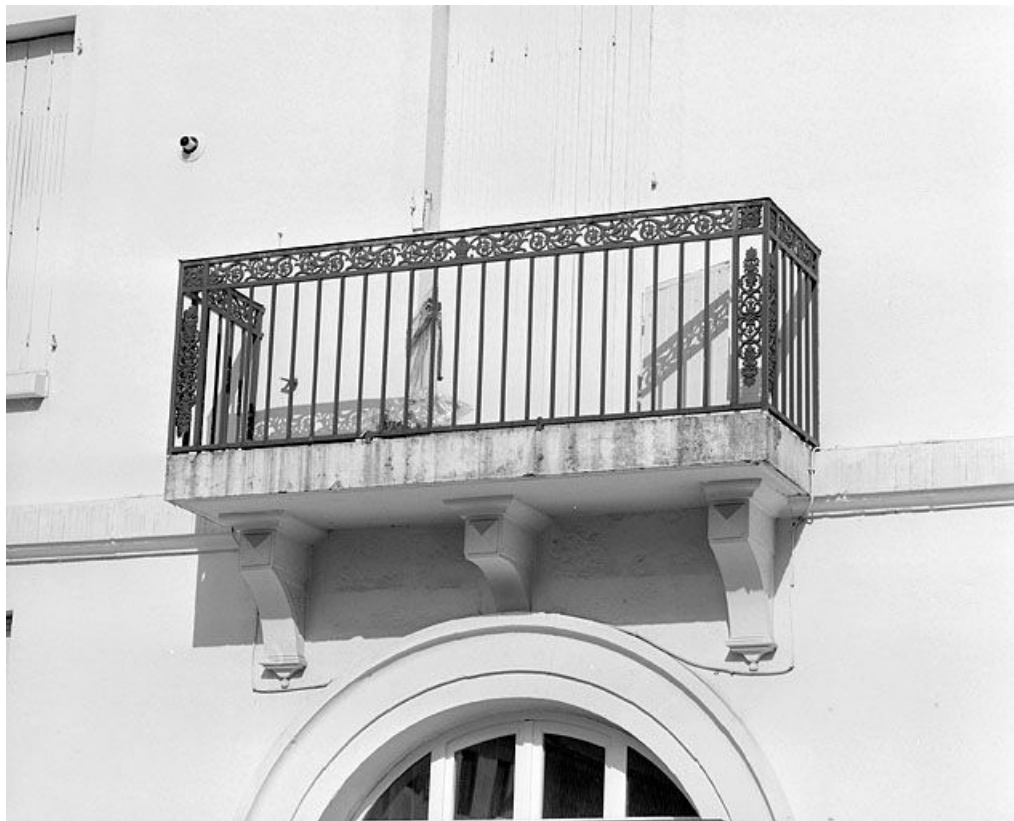
Façade latérale droite : balcon du premier étage.
