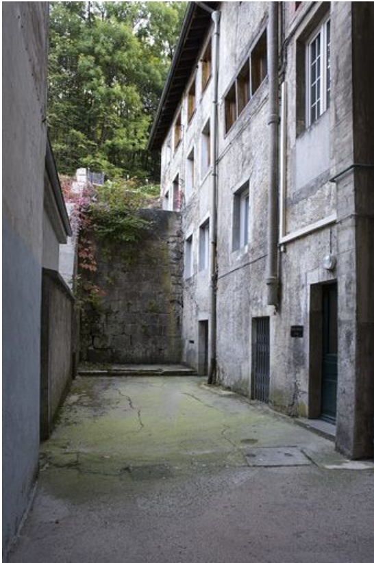
Cour, ancien atelier et mur de soutènement.
