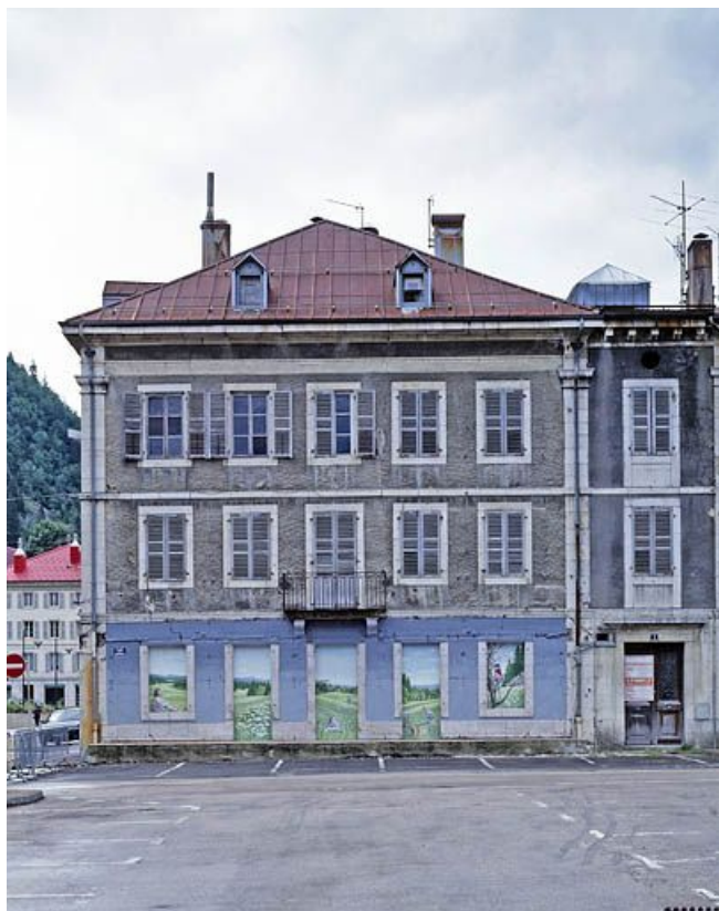
Le corps de bâtiment oriental.
