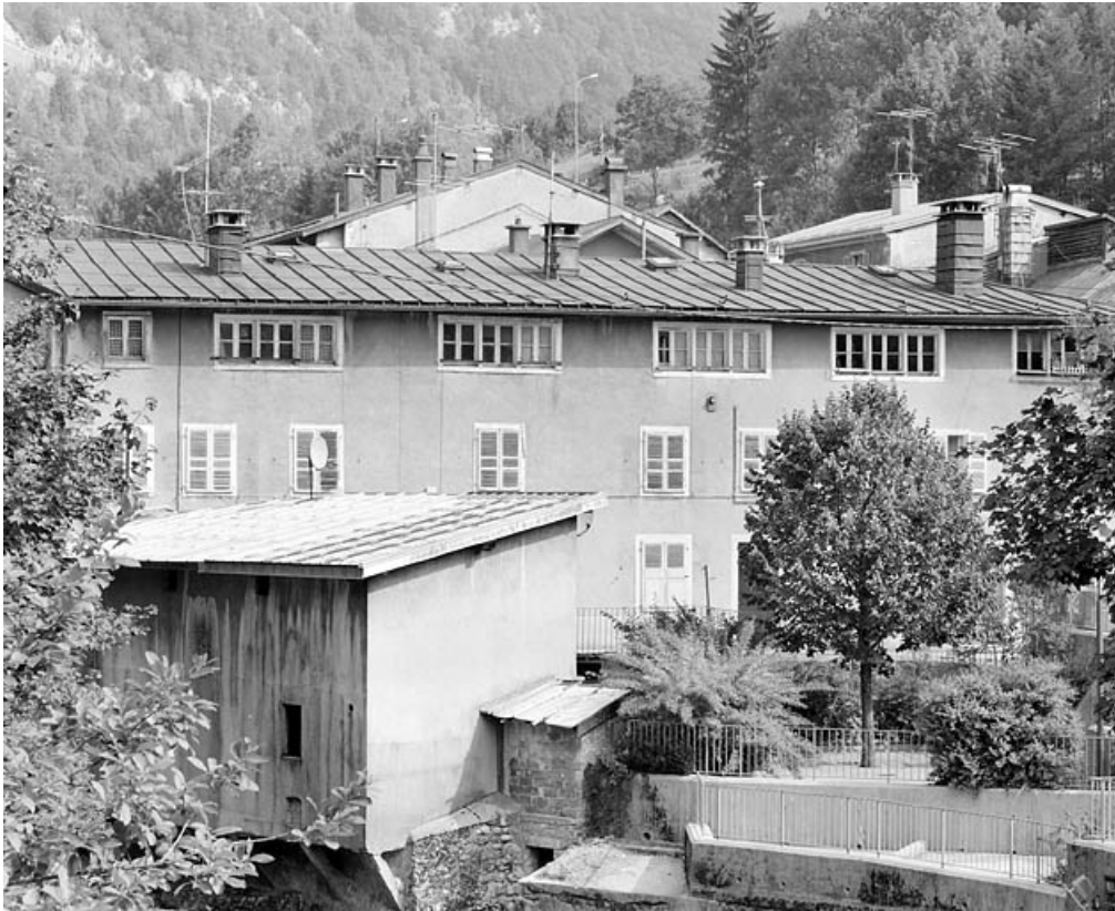
Façade principale : les deux étages carrés.
