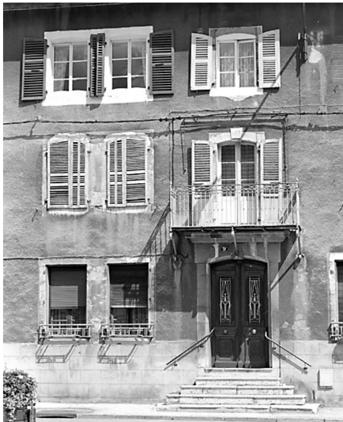
Façade antérieure : travées centrales.
