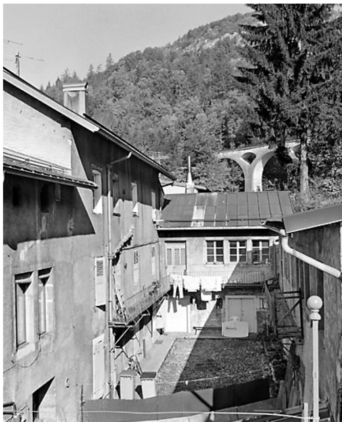
Façade postérieure, vue en enfilade.
