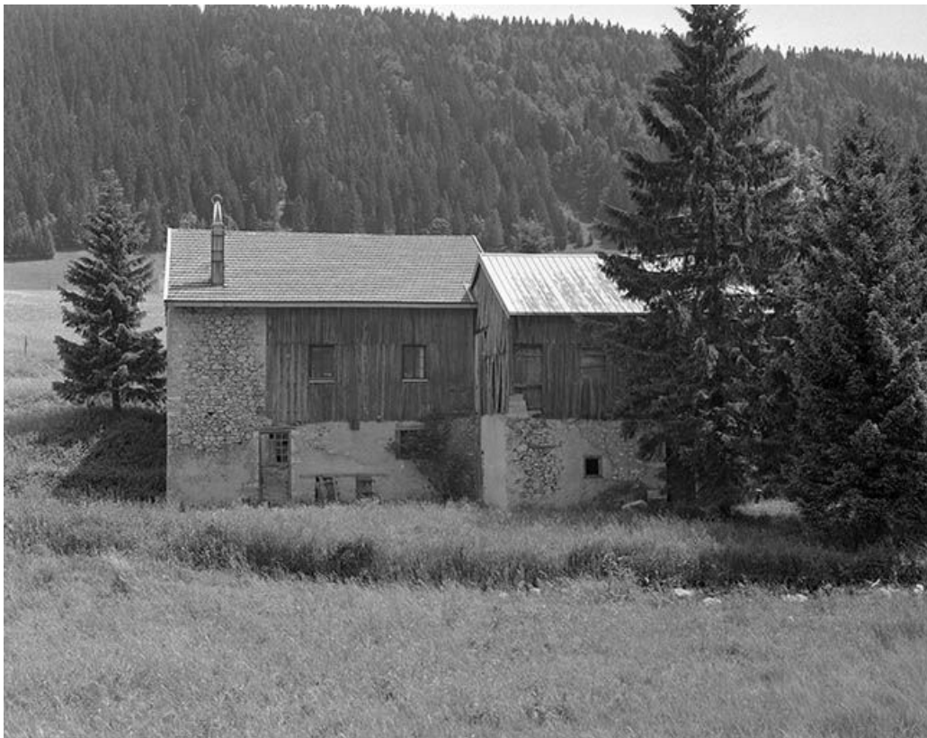
Façade le long de l'Orbe.
